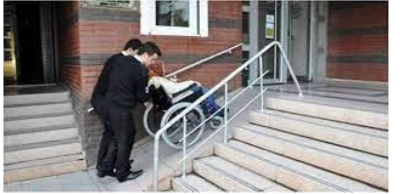
řekil:....Bina batı giriři
